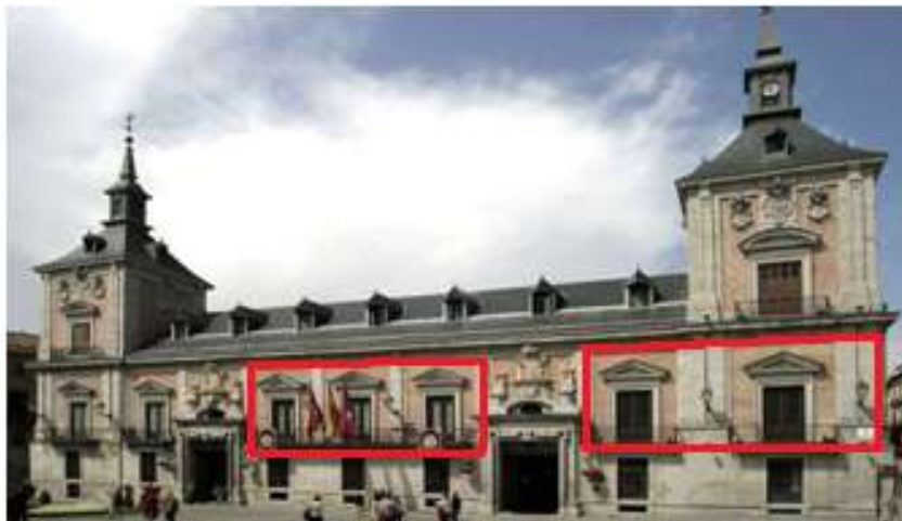
Fig. 44. Fachada del edificio, de piedra cárdena y ladrillo. Señaladas en rojo las ventanas del Salón de Plenos, izquierda, y del Oratorio, derecha. ( Volver pág 61 )
